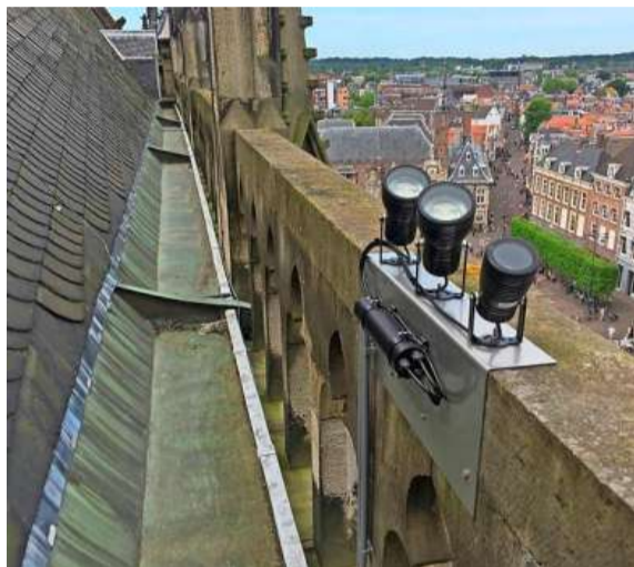
Boven de oude armaturen die aan vervanging toe zijn. Onder de nieuwe armaturen, die vanaf de grond onzichtbaar zijn voor het blote oog. FOTO'S VRIENDEN VAN DE GROTE KERK
